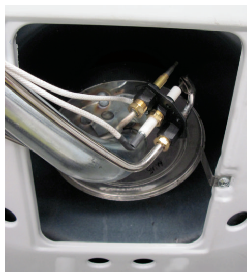
Skupina horáka s termočlánkom a piezo elektrickým zapalovaním
